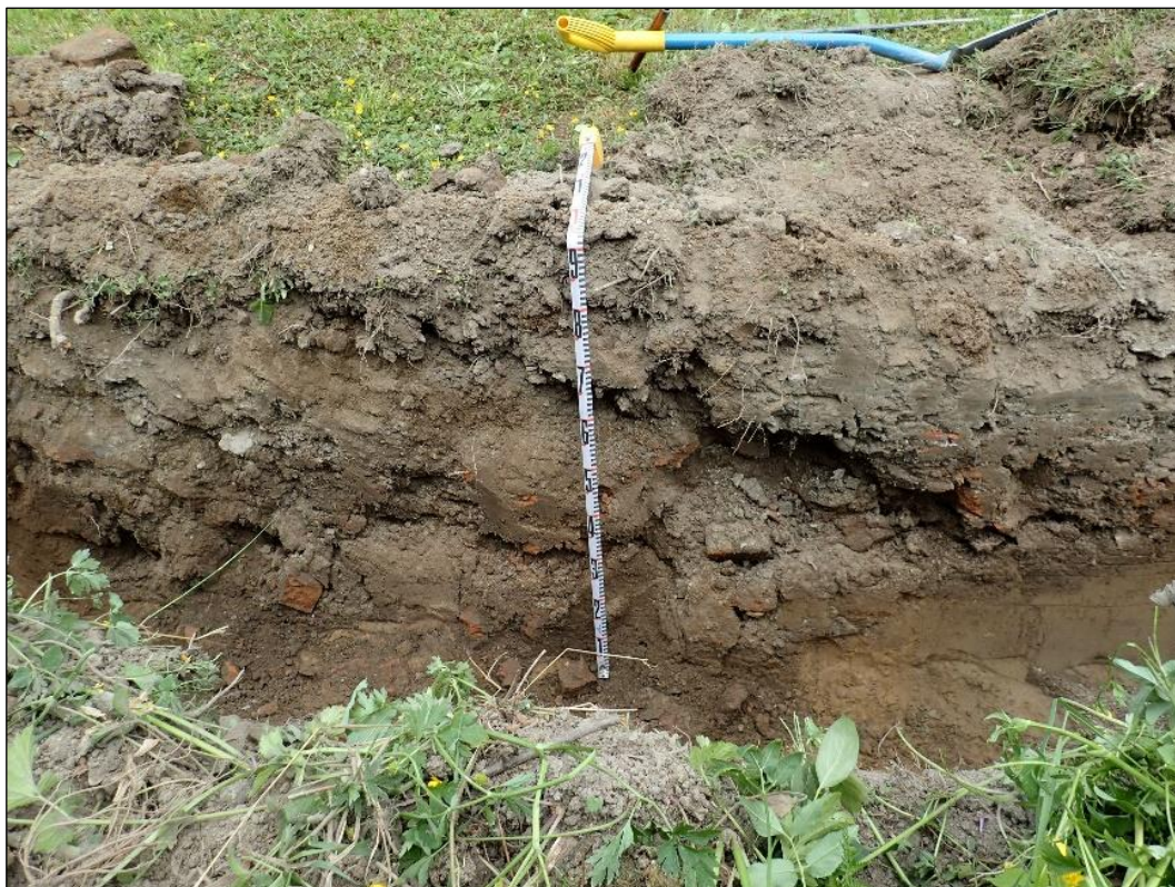
Suurimmaksi osaksi tiilen paloja, savea ja multaa sisältänyt jätekuopaksi tulkittu ilmiö sijaitsi valvonnassa kaivetun kaapeliojan pohjoisosassa. Kuvassa kohdan länsileikkaus – ilmiö jatkui myös ojan itäleikkauksessa.
