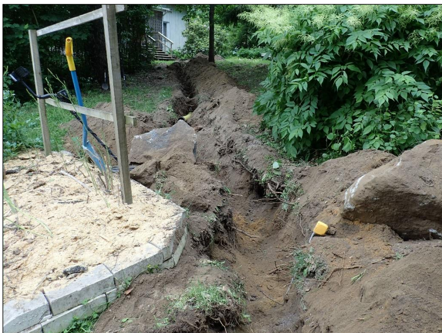
Pistohaaran valmista kaivantoa. Lounaaseen.
