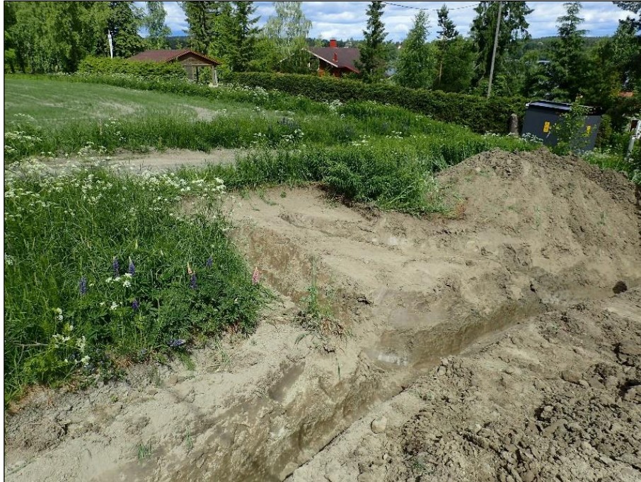
Yllä: muuntamo varten kaivettu alue. Kuvan etualalla näkyy kaapelioja. Luoteeseen. Alla: kaapeliojan korkeinta kohtaa. Kiinteistölle lähtevä pistohaara kaivettiin ojan mutkan takaa vasemmalle (länteen). Pohjoiseen
